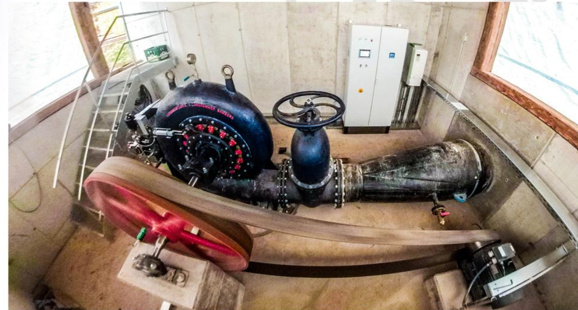
Anlage mit Umrichter zur Leistungssteigerung durch Drehzahlreduzierung
