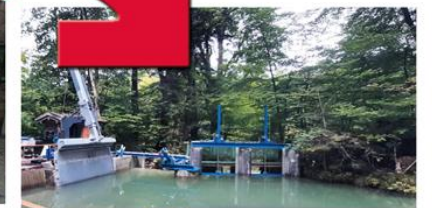
Erneuerung Einlaufbauwerk mit Rechenreiniger, Wehre
