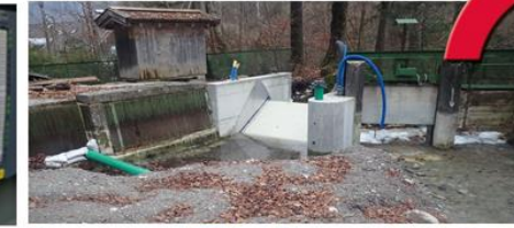
Erneuerung Einlaufbauwerk mit Rechenreiniger, Wehre
